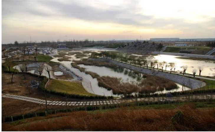
图 F4-17 多功能调蓄水体公园实景
