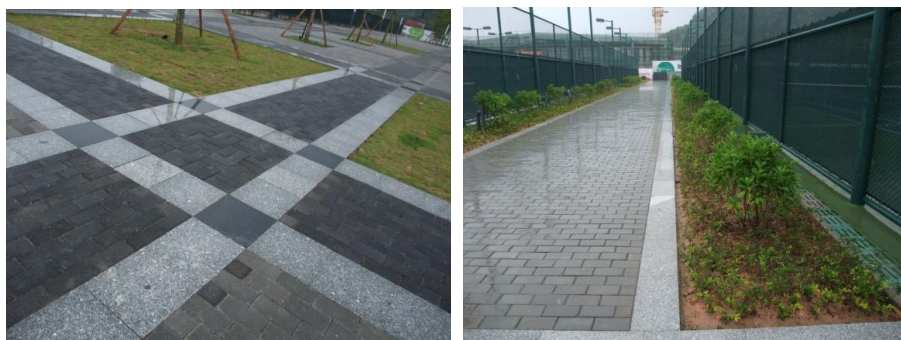
图 F4-5 透水铺装地面和下沉式绿地实景图
