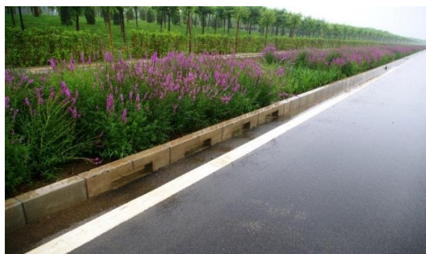
图 F4-15 科创十七街生物滞留带实景
